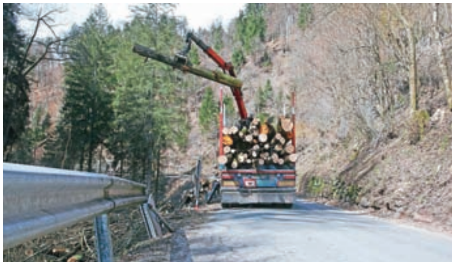
Začela se je sanacija zidov in brežin na kilometer in pol dolgem odseku državne ceste od Trebije do Hobovš. FOTO: GORAZD KAVČIČ
